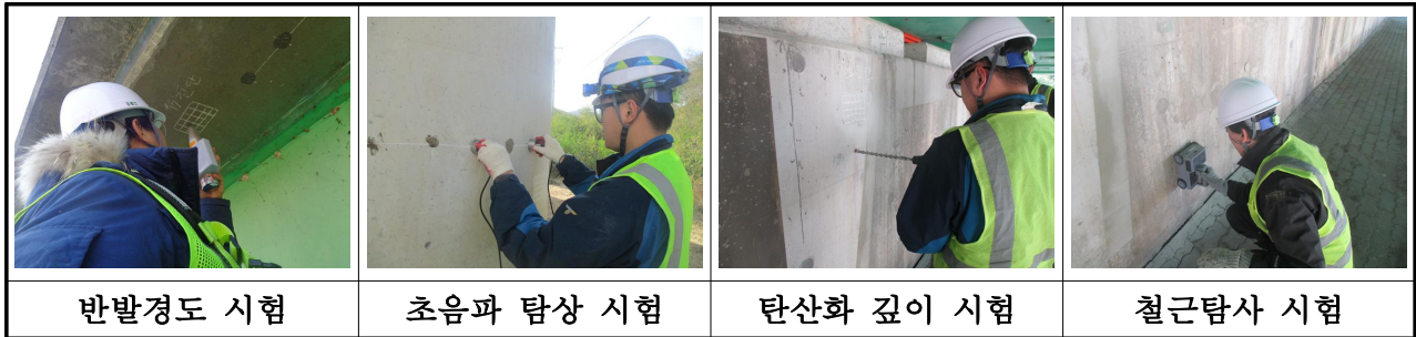
【사진 3.46】 콘크리트 내구성조사 전경
