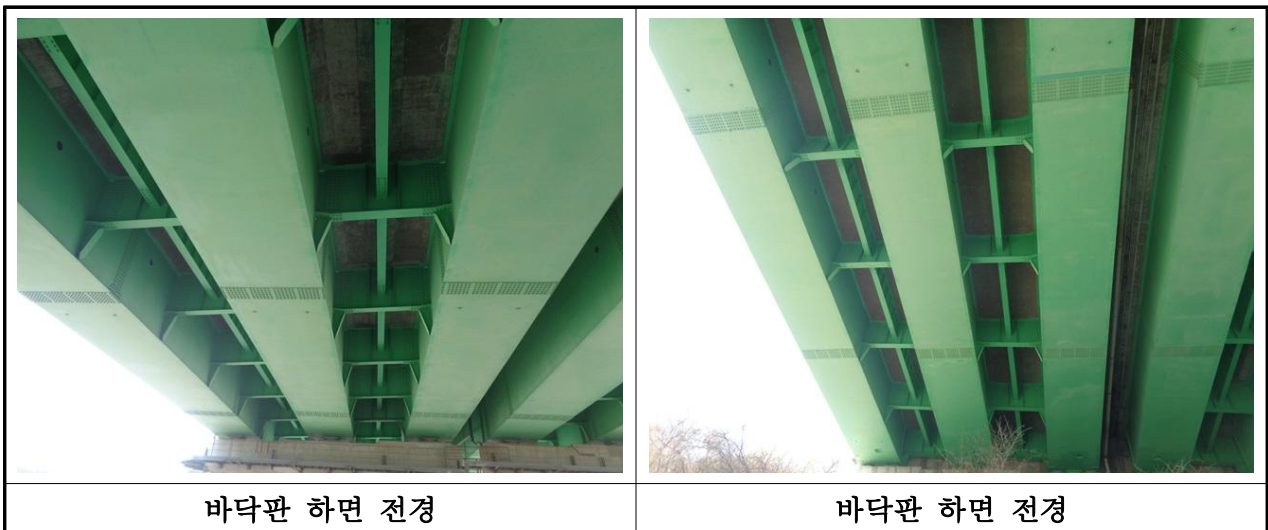
【사진 3.2】 바닥판 전경
