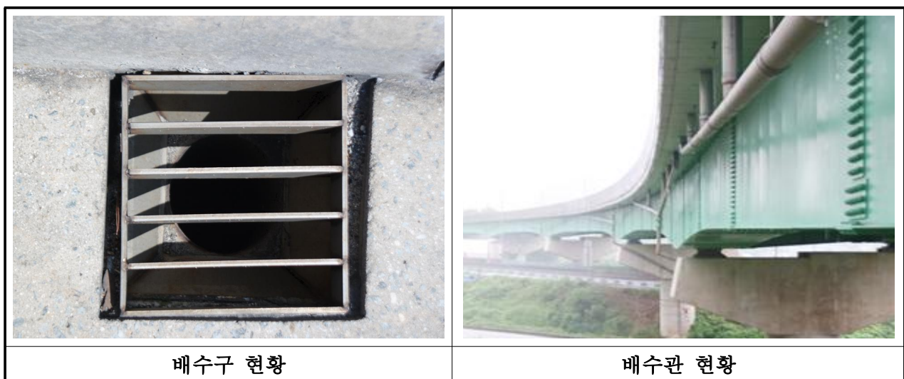
【사진 3.42】 배수구 및 배수관 전경
