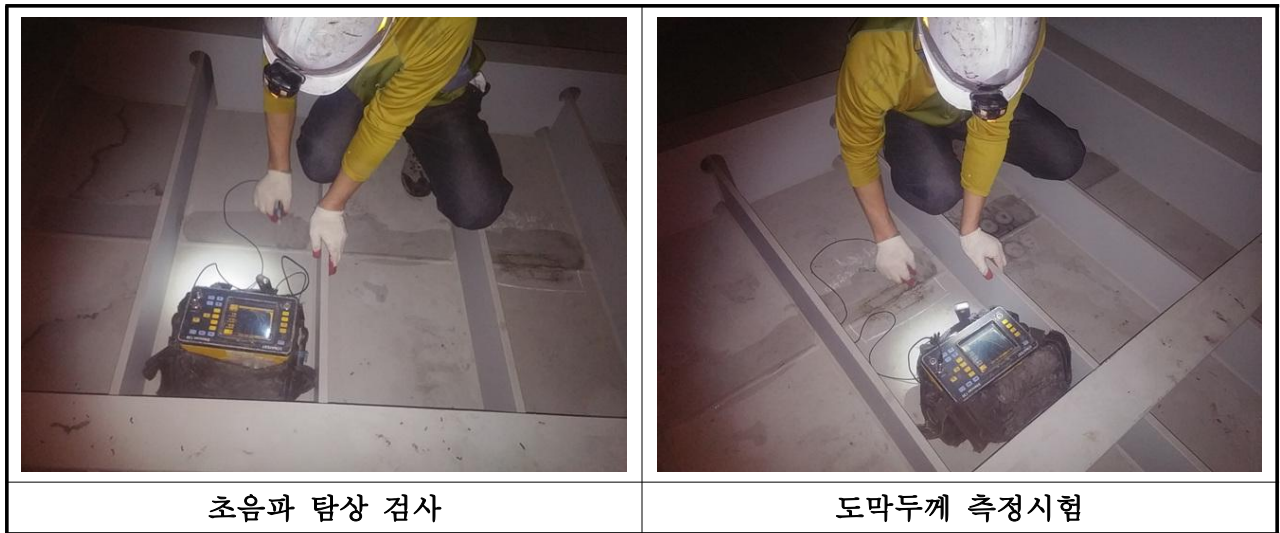
【사진 3.47】강재 내구성조사 전경
