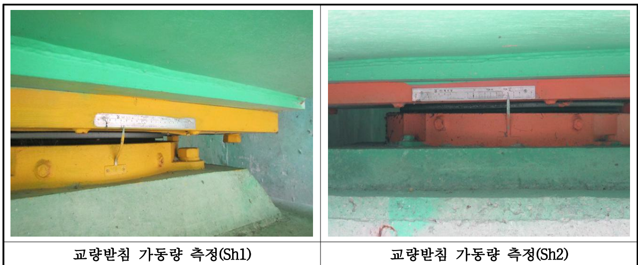
【사진 3.36】 교량받침 가동량 측정 전경
