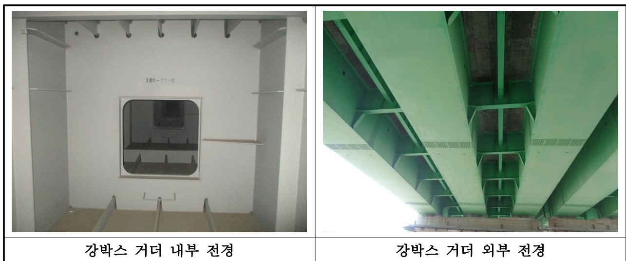
【사진 3.26】 강박스 거더 전경
