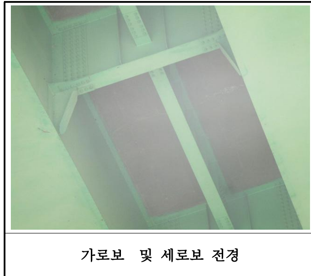
【사진 3.29】 가로보 및 세로보 전경
