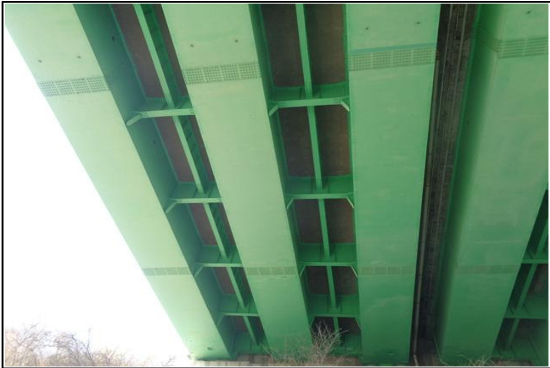
바닥판하면 및 거더 외부 전경
