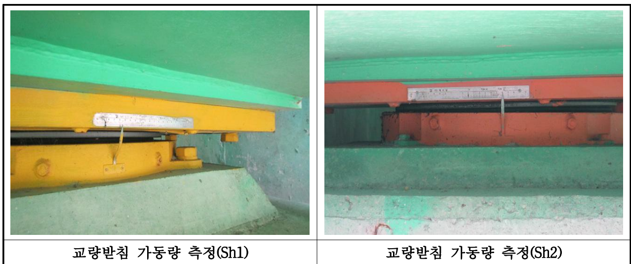
【사진 3.14】 교량받침 가동량 측정 전경
