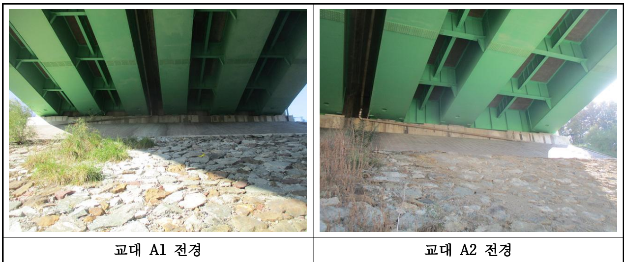
【사진 3.9】 교대 전경
