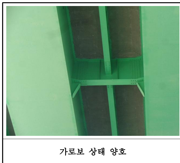
【사진 3.8】 가로보 및 세로보 손상현황
